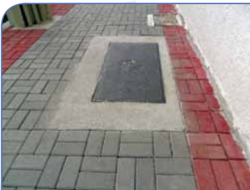
Acabamento em tampa de inspeção
