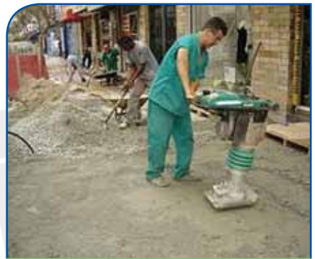
Compactação e nivelamento
