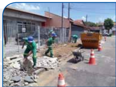
1º PASSO: Quebra e retirada de entulho
