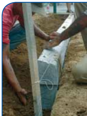
2º PASSO: Nivelamento do solo com a guia/sarjeta
