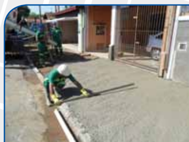
5º PASSO: Sarrafeamento do concreto
