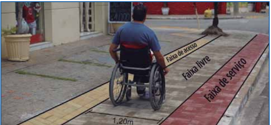
CALÇADA PRONTA DE PISO INTERTRAVADO
