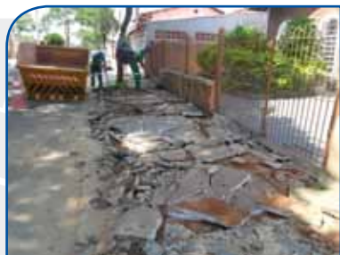
1º PASSO: Quebra e retirada de entulho
