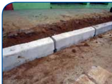
2º PASSO: Nivelamento do terreno com a guia/sarjeta
