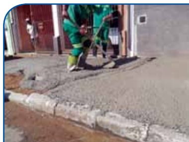
4º PASSO: Lançamento do concreto
