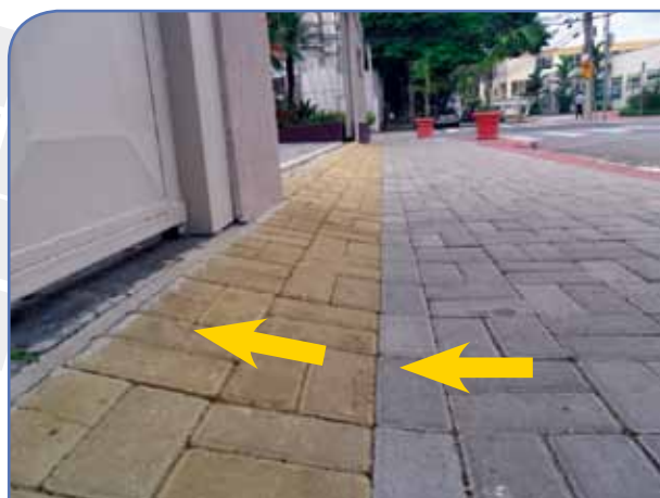
Detalhe de inclinação na faixa de acesso para entrada de carro
