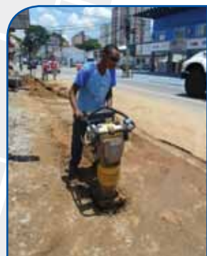
3º PASSO: Compactação do solo (Compactador)
