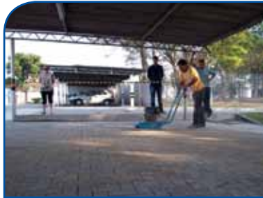
9º PASSO: Nova compactação com a placa vibratória para rejunte dos bloquetes
