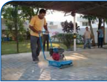
7º PASSO: Compactação e nivelamento do bloquete assentado com a placa vibratória
