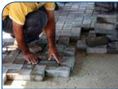
6º PASSO: Colocação e assentamento manual do piso
