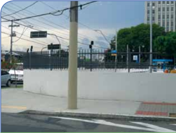
Calçada de piso intertravado com esquina cimentada
