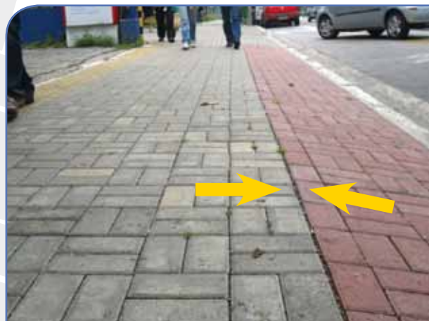
Detalhe de inclinação na faixa de serviço para entrada de carro
