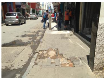
FOTO 09B: Calçada na rua Dr. Santos, inadequada ao caminhar. Registro Fotográfico: Arq. e Urb. Ana Luísa Pires, 2015.
