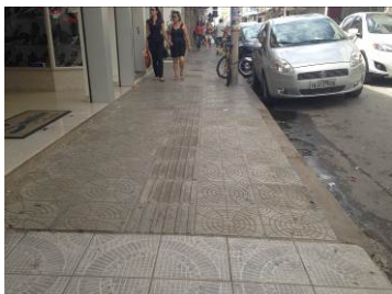
FOTO 10B: Calçada na rua Padre Augusto, recuperada pelo proprietário e adequada ao caminhar. Registro Fotográfico: Arq. e Urb. Ana Luísa Pires, 2015.
