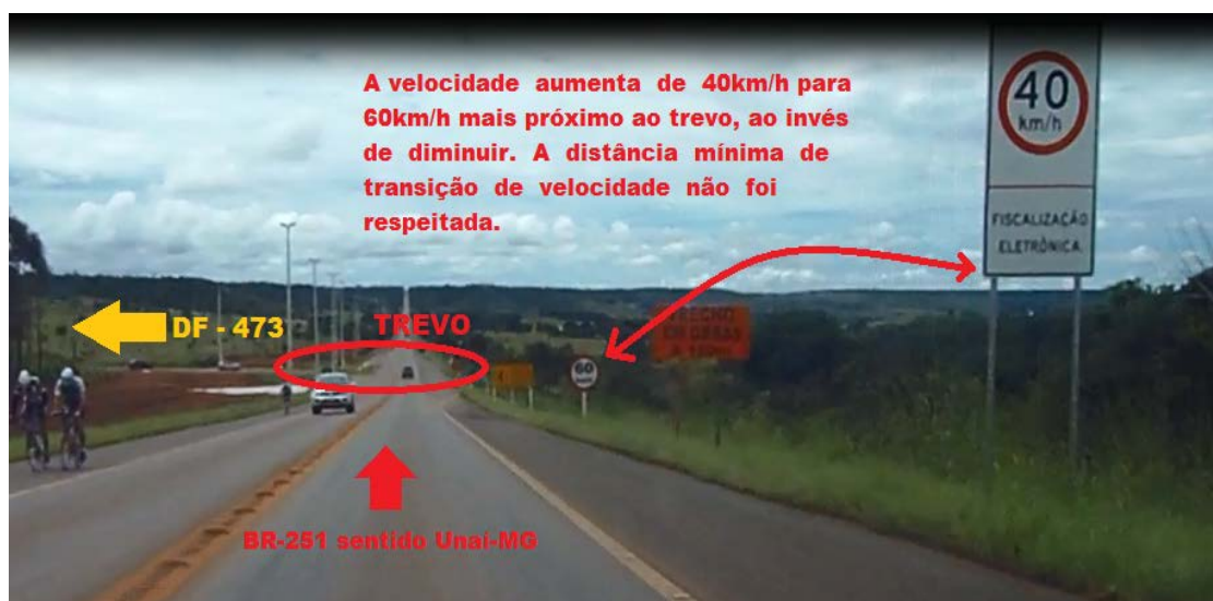
Figura 8 - Aumento da velocidade próximo ao entroncamento no km 33,00.
