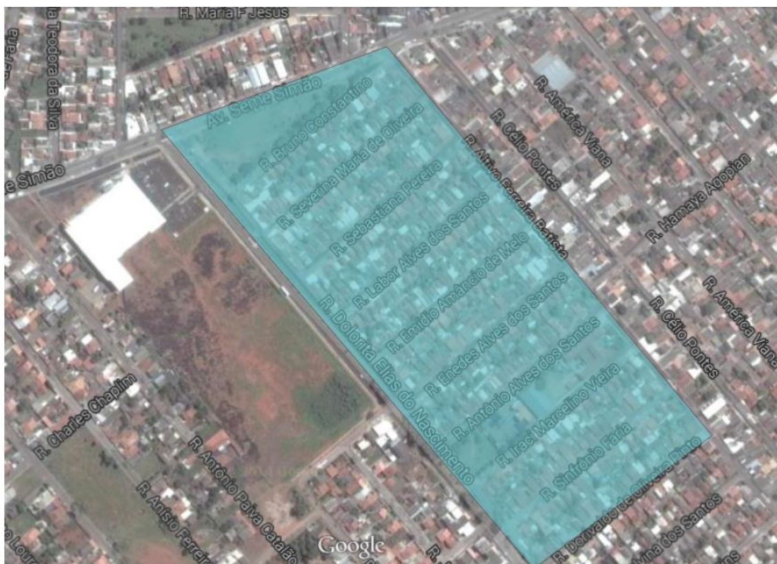
Figura 01 – Vista aérea da quadra estudada localizada no bairro São Jorge da cidade de Uberlândia-MG
