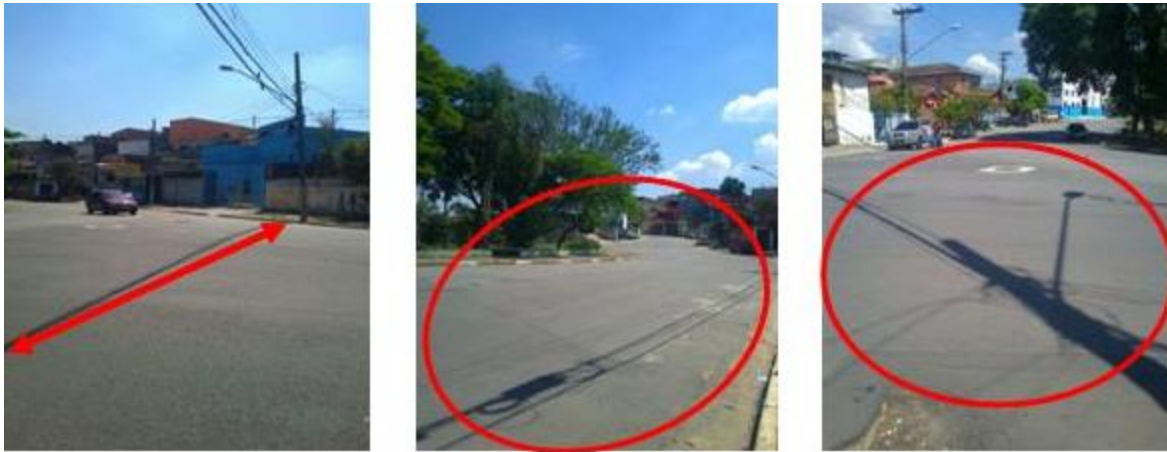
Figura 7 - Fotos da Praça Serafino Correia antes da implantação do projeto de sinalização horizontal e vertical. Grandes extensões de asfalto sem faixas de travessia
