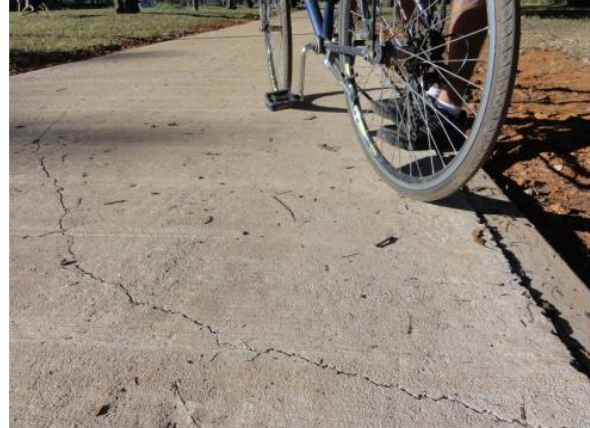
Figuras 8 e 9: Buraco e rachadura grandes na ciclovia da L2 Norte
