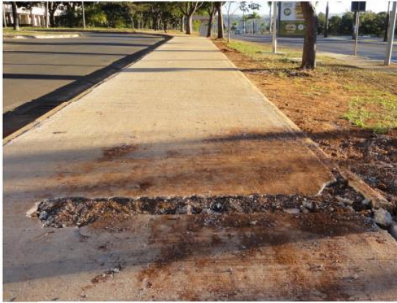
Figuras 8 e 9: Buraco e rachadura grandes na ciclovia da L2 Norte
