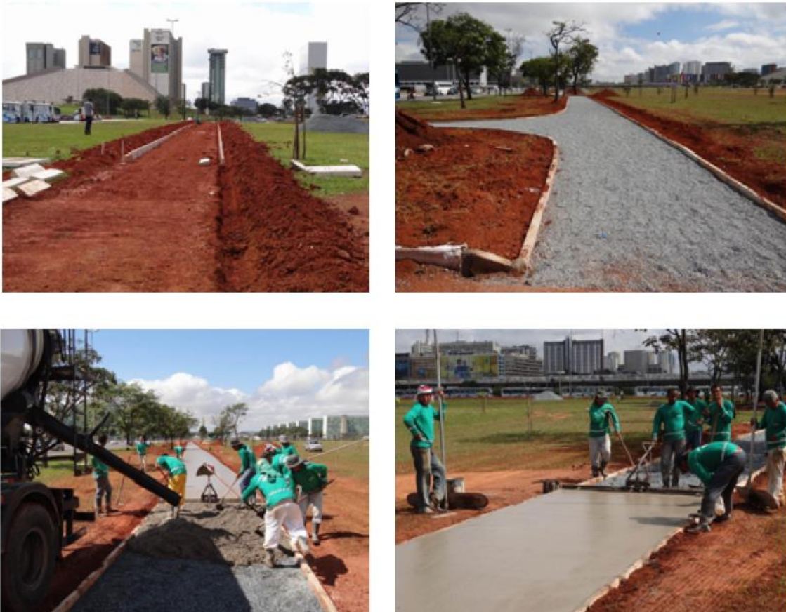
Figura 3: Processo de execução de vias cicláveis no Eixo Monumental
