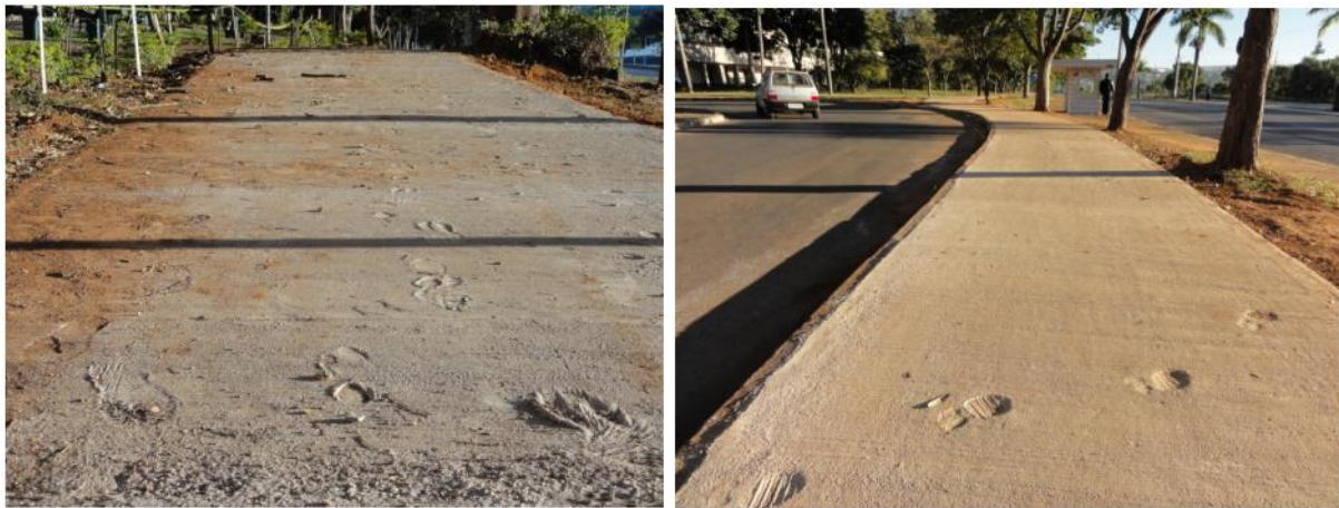
Figuras 6 e 7: Marcas de pisoteio e irregularidades na ciclovia da L2 Norte
